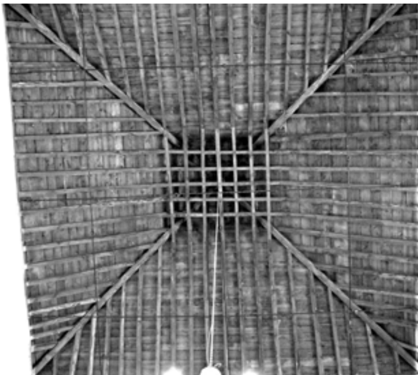
Armadura de la iglesia de Nieves sobre la capilla mayor
