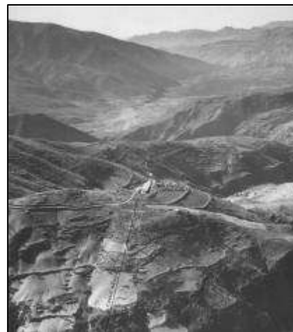
Cable aéreo y estación intermedia
